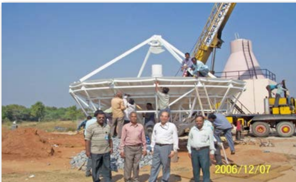
स्थापना के दौरान एंटीना रिफ्लेक्टर और आरएफ फीड की असेंबली Assembly of Antenna Reflector and RF Feed during installation
