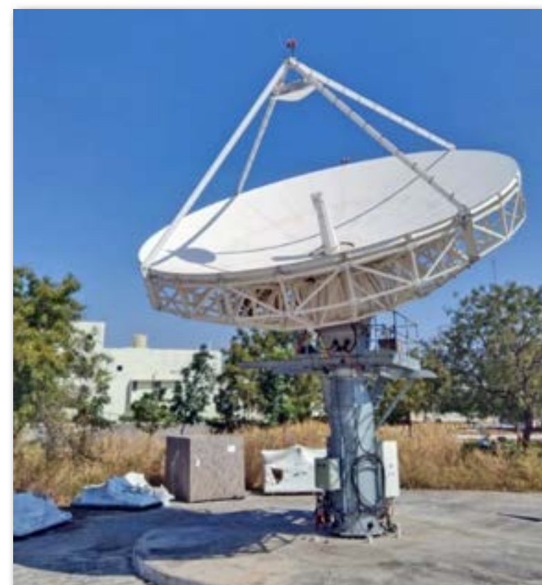
IMGEOS कॉम्प्लेक्स में 9.1 मीटर व्यास वाला GISAT एंटीना सिस्टम 9.1 m dia GISAT Antenna System at IMGEOS Complex
