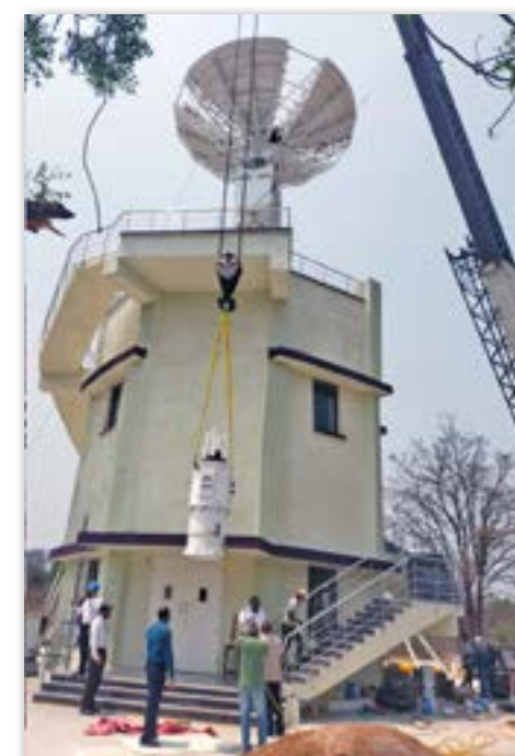
स्थापना के दौरान एंटीना रिफ्लेक्टर और आरएफ फीड की असेंबली Assembly of Antenna Reflector and RF Feed during installation
