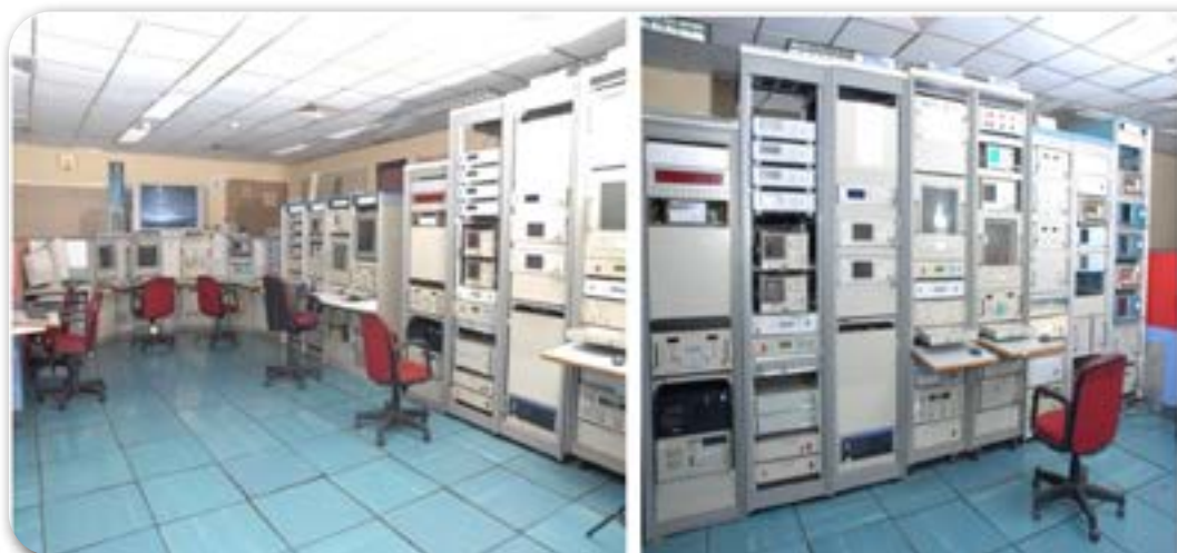
आईआरएस-1सी/1डी/ओएस-1 नियंत्रण कक्ष – प्राप्त प्रणाली और वास्तविक समय डेटा अभिलेख IRS-1C/1D/OS-1 Control Room – Receive System & Real-time Data Archival
