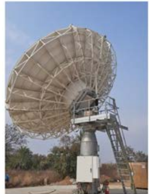
केयू बैंड एंटीना संरचना Ku band antenna structure
